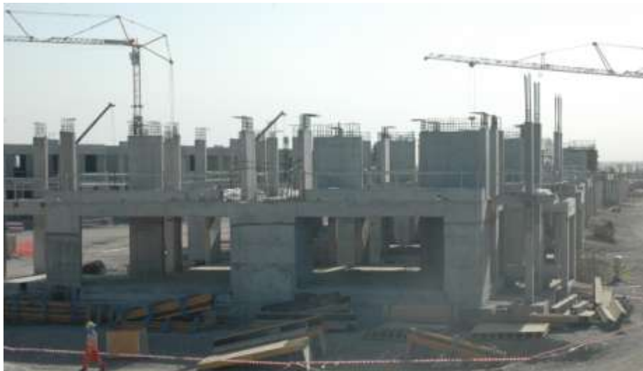
Πολυκατοικία σε φάση κατασκευής
