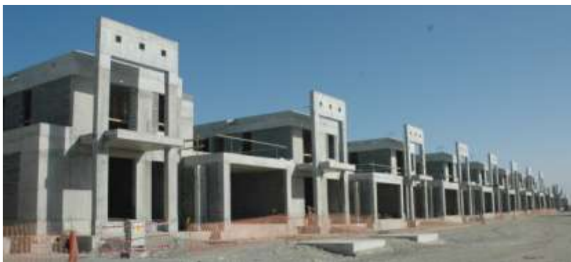
Βίλλες σε φάση κατασκευής. Έχουν ολοκληρωθεί οι εργασίες σκυροδέτησης
