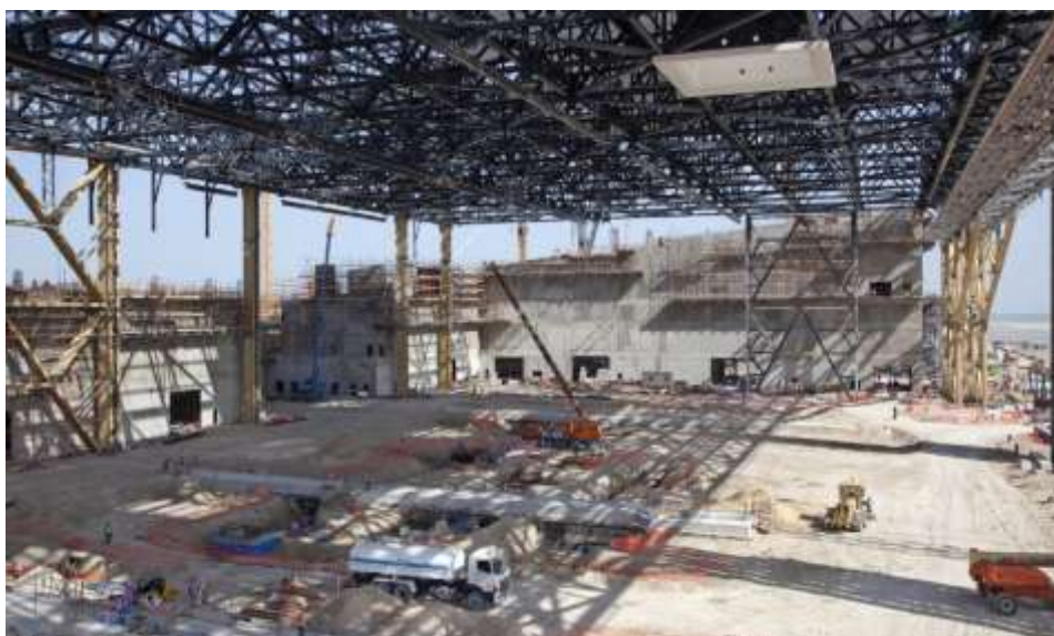
Φάση κατασκευής ενός από τα δύο υπόστεγα αεροσκαφών. Η μεταλλική στέγη έχει αναρτηθεί στην τελική της θέση
