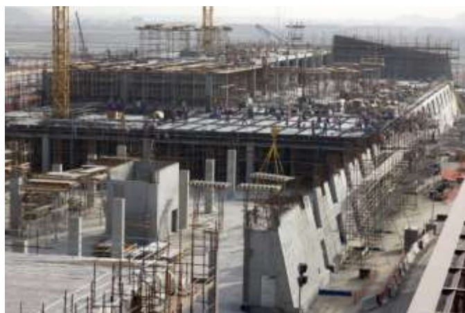
Κατασκευή του κτηρίου επισκευών και συντήρησης
