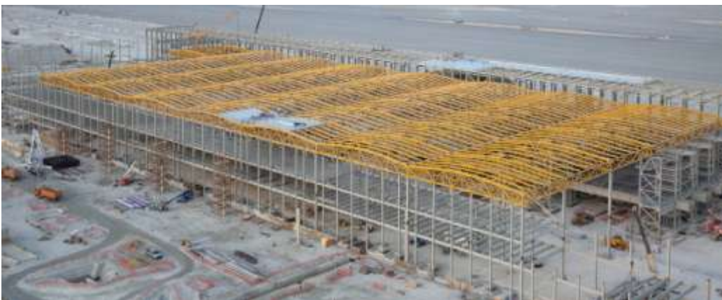
Εξωτερική προοπτική άποψη του κτηρίου σε φάση κατασκευής
