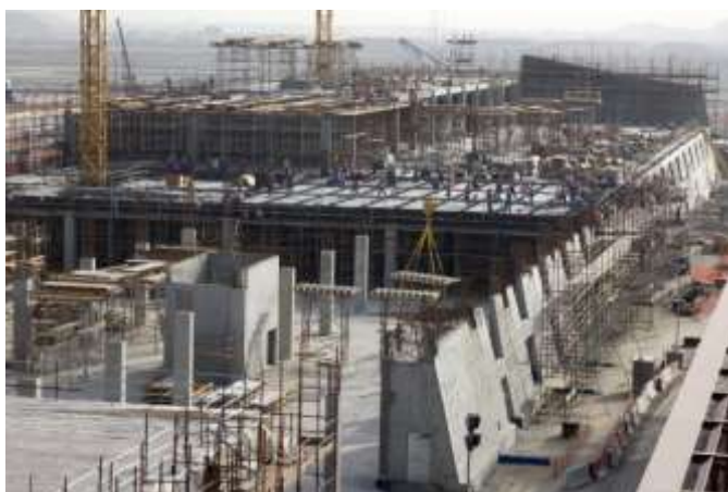
Κατασκευή του κτηρίου επισκευών και συντήρησης
