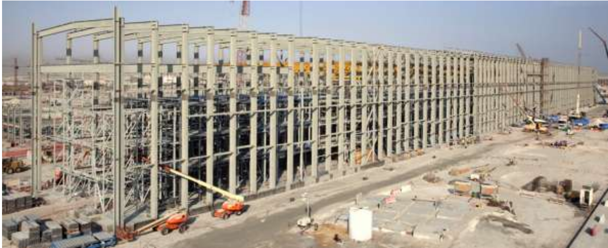
Εξωτερική άποψη του Κτηρίου Αποθήκευσης κατά τη φάση κατασκευής
