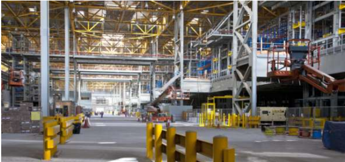
Εσωτερική άποψη του Εμπορευματικού Σταθμού
