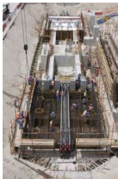
Θεμέλια κεντρικού πλαισίου με καλώδια προεντάσεως της συνδετήριας δοκού
