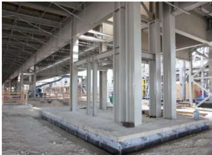
Εσωτερική άποψη Εμπορευματικού Σταθμού - Μεταλλικές κολώνες θεμελιωμένες σε πασσάλους
