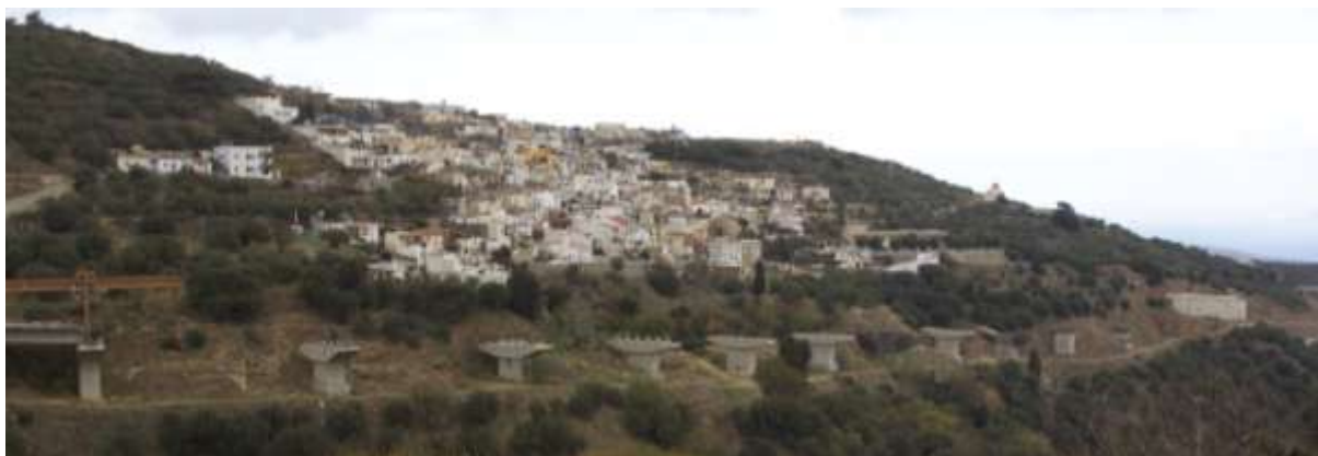
Εικόνα των κατασκευασμένων βάθρων (τμήμα μεταξύ Μ10 και Μ20)
